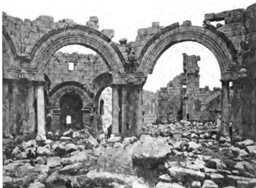
Fig. 34. — Centre des sanctuaires de Siméon le Stylite en Syrie. Substitution à l'architrave, de l'archivolte reposant directement, comme elles, sur le chapiteau.
